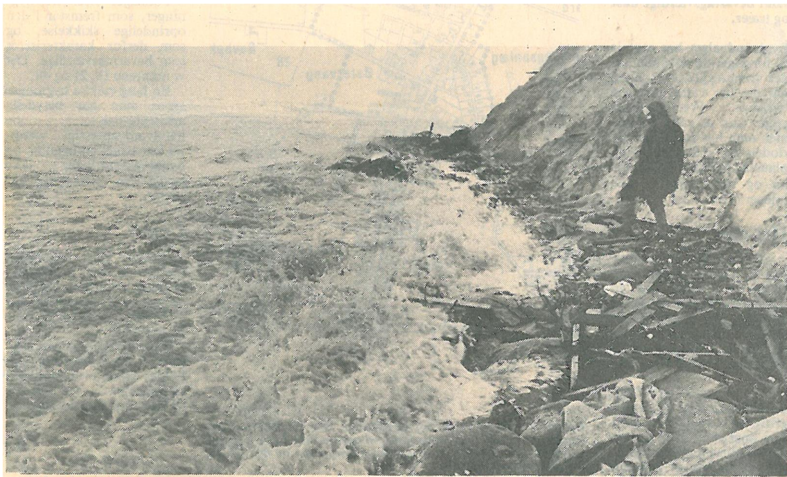
Det går hårdt til ved Harrerenden, når havet rigtigt står på, og især når det er højvande. Så slår sommerhusforeningens egen skråningsbeskyttelse med løse kampesten ikke til.
